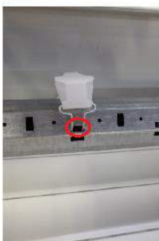
Maak de klemmen van het rolluik vast in de bovenste opening.
